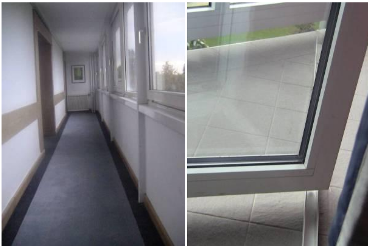
В этом отеле удивительная конструкция окна-двери на лоджию. Дверь выдвигается по рельсам легко и закрывается легко и плотно.
