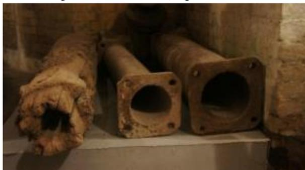
В трубах и кроется секрет петергофских фонтанов – они берут воду из родников возвышенности за 20 км от дворца, и вода попадает в фонтаны под напором благодаря перепаду высот. Поэтому фонтаны и работают ежедневно. А в Версале фонтаны работают от насосов, поэтому они включаются только иногда. Так было и при Петре I, и наш царя, беря Версаль за образец, существенно улучшил исполнение фонтанных композиций. В парке ещё много прекрасных фонтанов.
